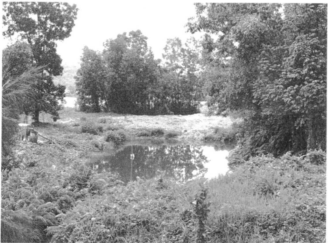
ภาพที่ 3-4 บ่อดักตะกอนที่รองรับน้ำจากพื้นที่โครงการและพื้นที่โรงแต่งแร่
